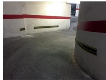
Diseñado para dotar de protección a zonas que requieran especial protección contra impactos de máquinas durante la maniobra de carga y descarga o el paso de vehículos.
