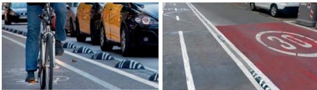
Son elementos diseñados para servir de barrera contra la invasión de vehículos en el carril bici, pero en el caso de que se produzca no suponga un daño importante. Se recomienda la instalación mediante varilla roscada Ø12 mm + resina epoxi.
