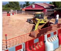
Llenado y vaciado a través del orificio superior. Fácil apilado y almacenamiento. Amplia cobertura en carretera. 550 u. por trailer. Sobre esta barrera le podemos insertar la barrera doubletop.
